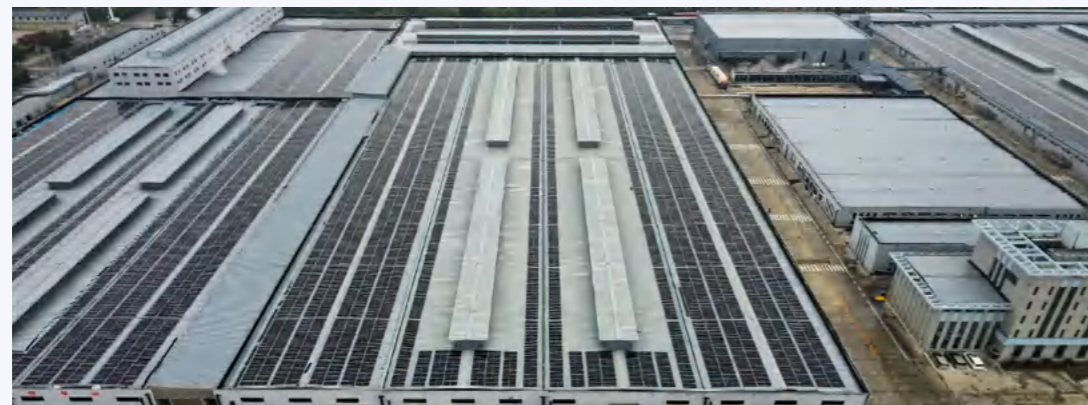
公司厂区光伏电站
